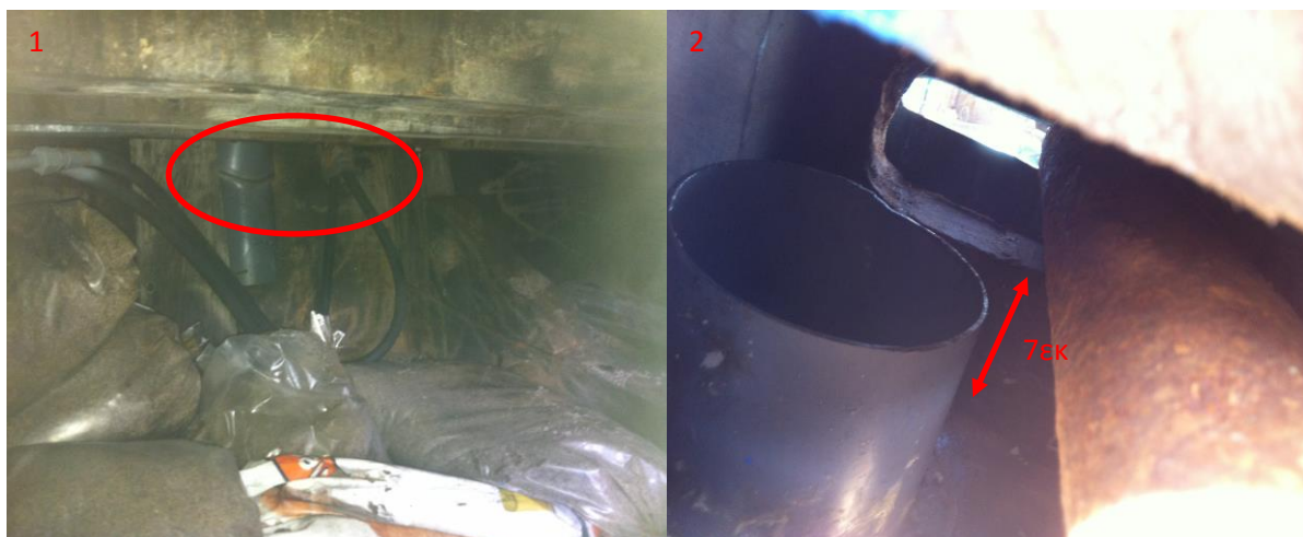
Εικόνα 6: Φωτογραφία 1: Ο σωλήνας αερισμού μηχανοστασίου και οι σωλήνες μηχανισμού πηδαλιουχίας στην εσωτερική πλευρά του μηχανοστασίου σκάφους. Φωτογραφία 2: Ο σωλήνας αερισμού από την εξωτερική πλευρά του καταστρώματος και η οπή στον καθρέπτη της πρύμνης, εντός της ξύλινης κατασκευής.
